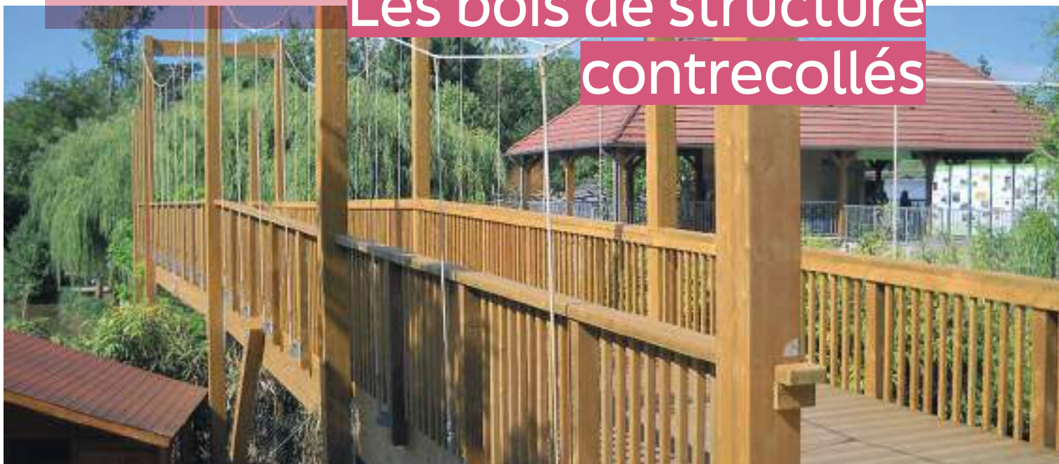
Pont avec poteaux contrecollés – pin du Nord rouge – autoclave vert.
