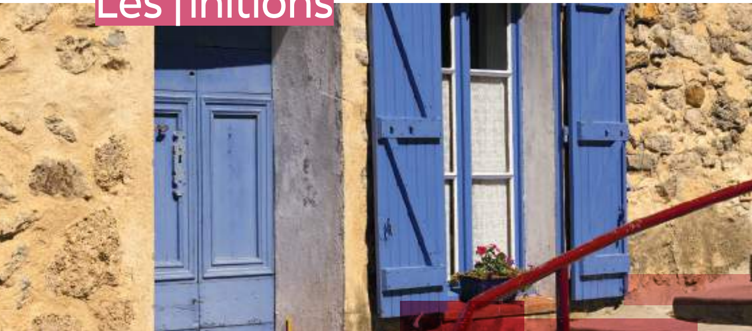
Exemple de mise en œuvre.
