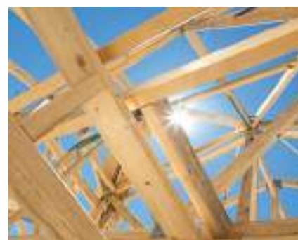
Charpente brute – pin sylvestre de France.
